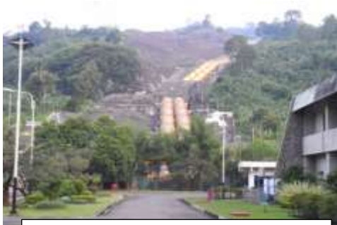
サグリン発電所 2010年3月
